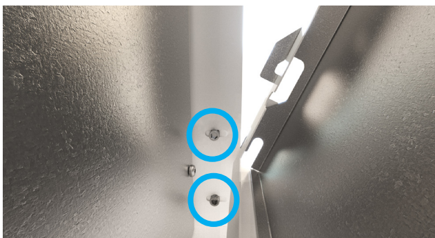
Montering av den kaklingsbara ramen.
