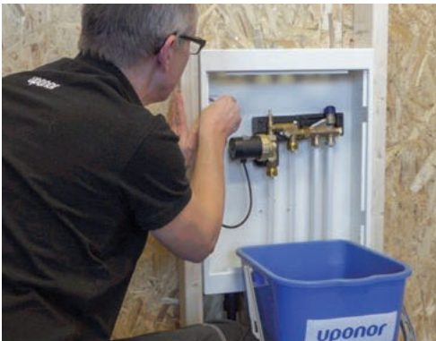
13. Anslut till nätspänning och starta värmesystemets primärpump.
